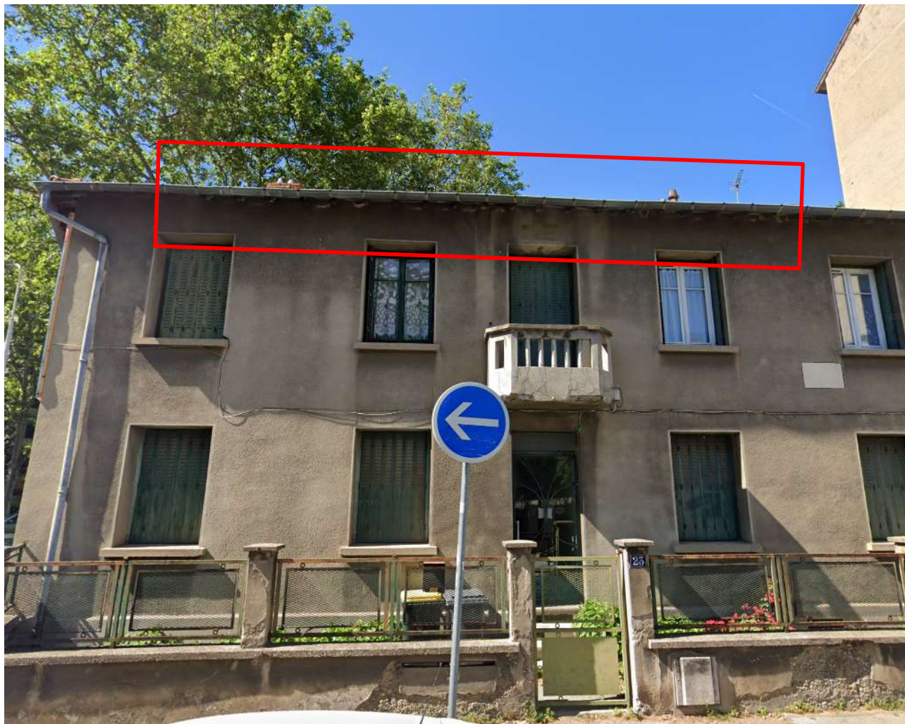
Immeuble ancien portant des restes de nids, 23 rue André Bollier, Lyon (7 e ) – photo Google Street View 2019
