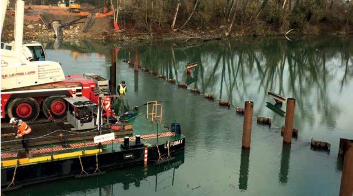
Intervention sur un site fortement sensible aux risques de pollution
