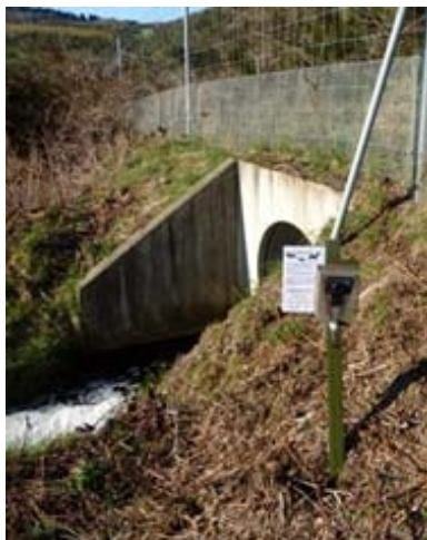
Pose à l'extérieur de l'ouvrage sur piquet métallique
