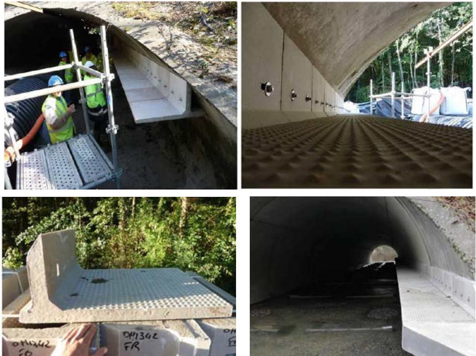
Préfabriqués pour la réalisation de l'encorbellement (Photos ASF)
