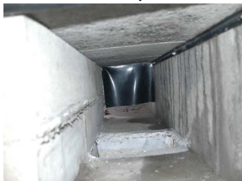
Vue intérieure du collecteur
