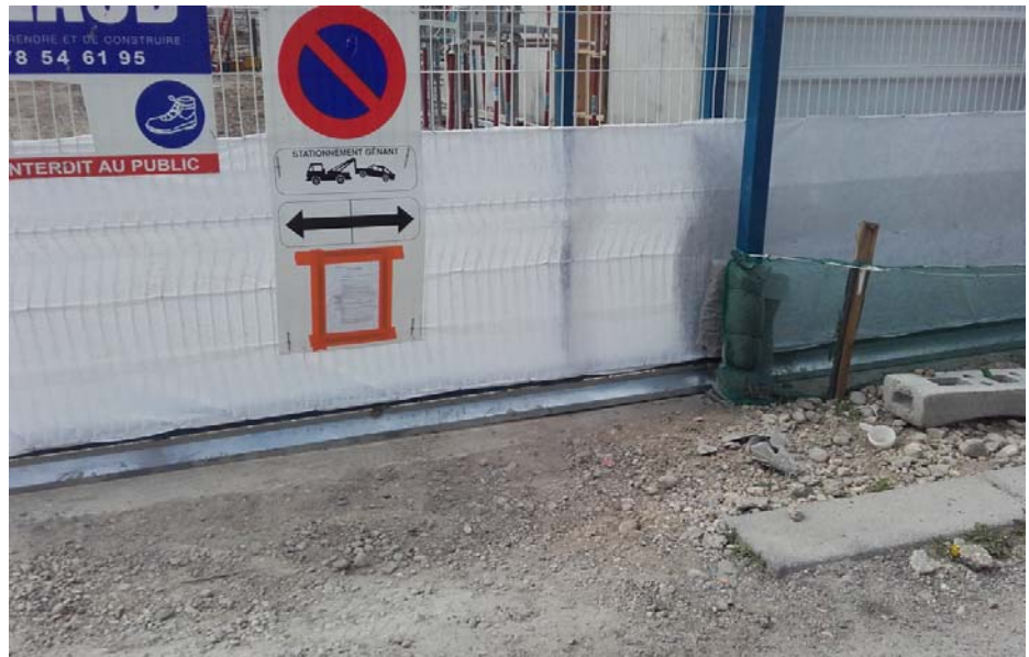
Dispositif de portail de chantier avec bavette anti-batraciens : Photo : Ecosphère
