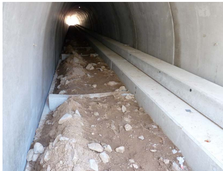
Exemple de banquette pleine dans un ouvrage neuf – photo Ecosphère (A89)
