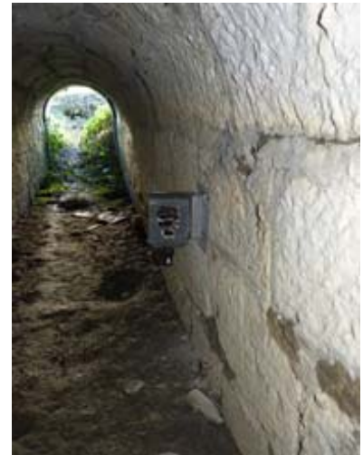
Pose dans un ouvrage
