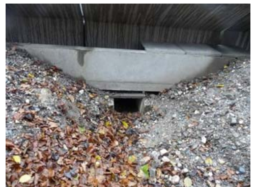
Sortie du passage sous la chaussée
