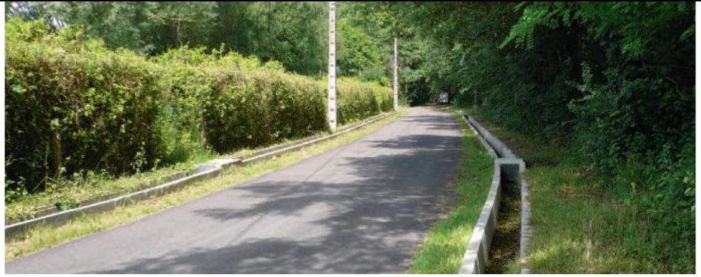
Exemples de caniveaux à sens unique (Photo : internet)
