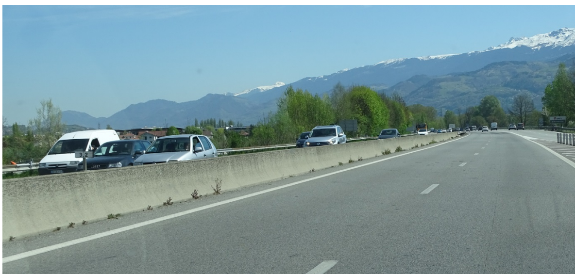
Ci-dessus : Glissière de Béton Adhérent (photo Ecosphère)
