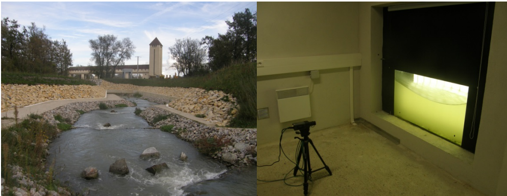
La rivière de contournement du barrage de Jons, avec son dispositif de suivi. Photos JL Michelot, Ecosphère.
