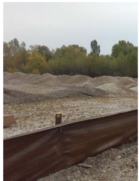
Bâche tendue fixée sur des poteaux bois – Photo : Ecosphère
