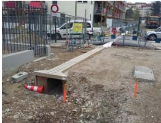
Passage à petite faune de la ZAC Maisons Neuves en cours de travaux - Photo Ecosphère.
